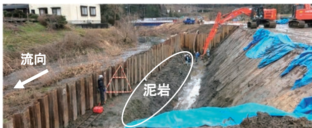
図-1 鋼矢板による仮締切
