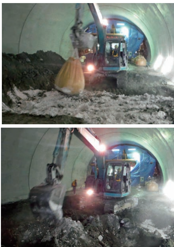
写真5 不溶化処理状況（上：不溶化材散布， 下：バックホウによる攪拌・混合）
