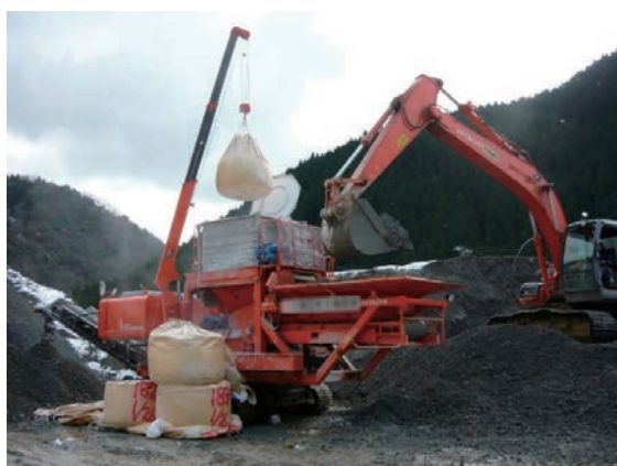
写真3 酸化マグネシウム系材料による 現場での不溶化処理状況 (自走式土質改良機を用いた混合状況)
