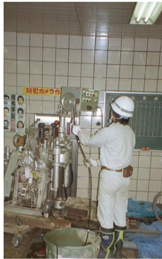
● 地下鉄構内での残置杭探査状況
