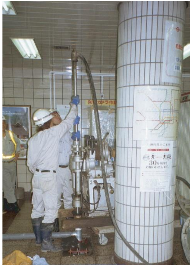
● 地下鉄構内での残置杭探査状況
