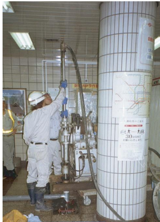
● 地下鉄構内での残置杭探査状況
